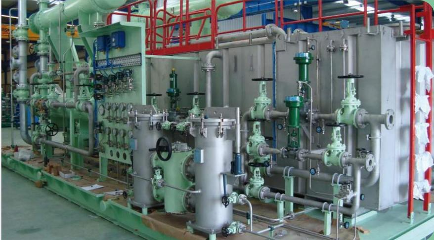
El procedimiento del **Hidroflushing**® consiste circular aceite nuevo o usado (filtrándolo previamente), por el sistema de lubricación, sello o control de la maquinaria, utilizando by-pass mediante mangueras flexibles, antes y después de los cojinetes, con el fin de que los contaminantes que recoja el aceite al fluir por las tuberías de presión y retorno de aceite, no los contamine.
